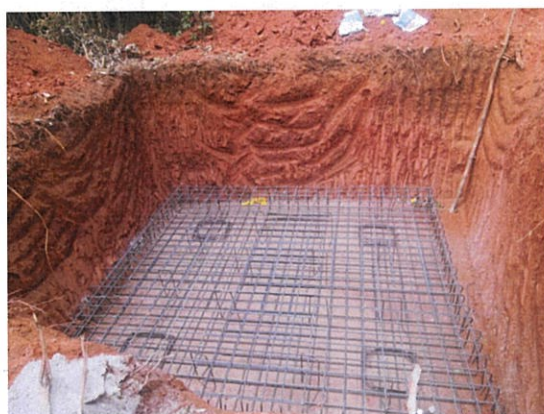
图 4-2（组） 瞭望塔基础开挖
