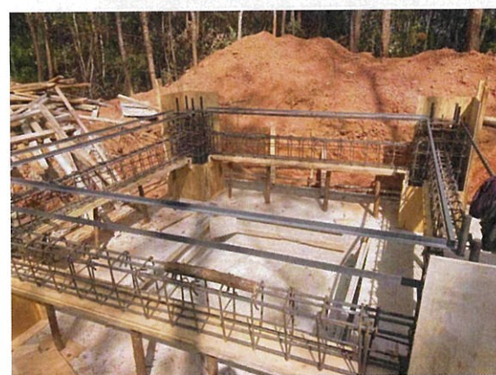
图 4-3（组） 瞭望塔基础施工
