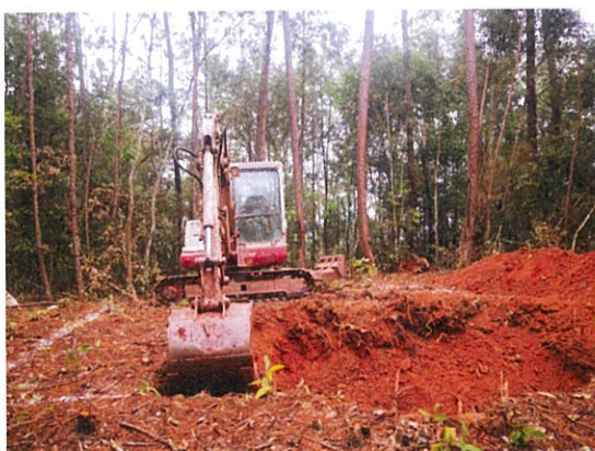
图 4-2（组） 瞭望塔基础开挖
