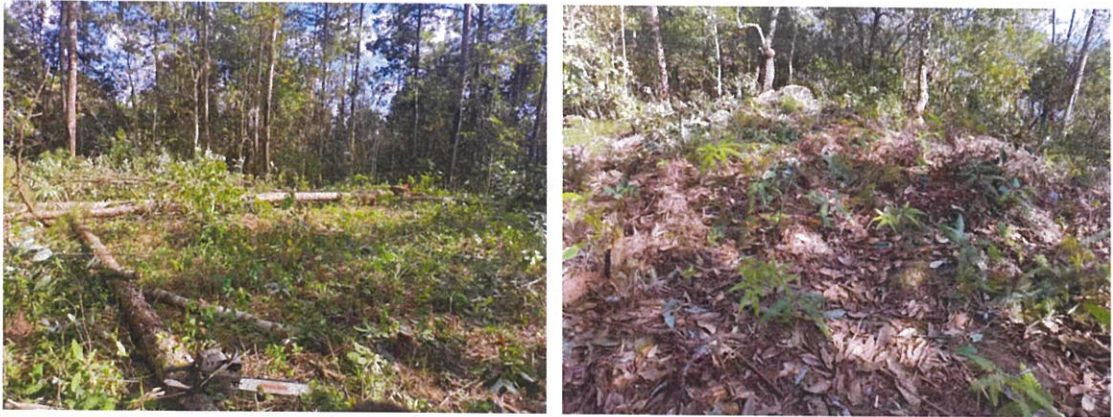
图 4-1（组） 瞭望塔塔基林木清理
